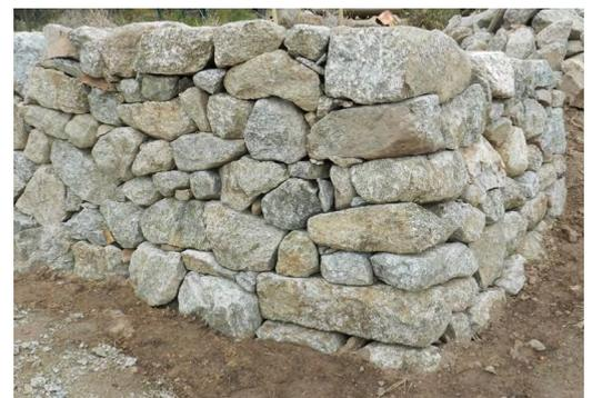
Appareillage de la chaîne d'angle
