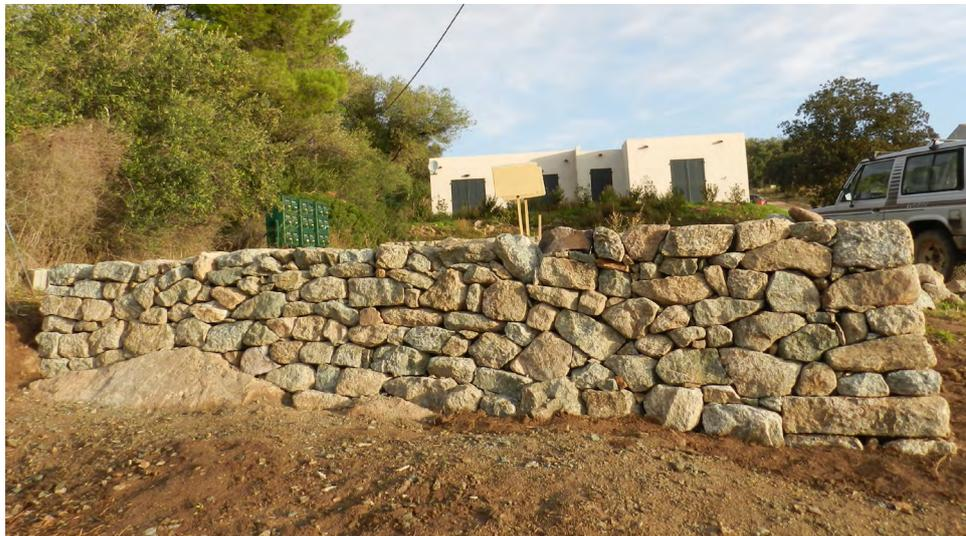
*Noter l'affleurement de la roche mère sur le côté gauche, qui a nécessité une taille de mise en forme de la fondation*
